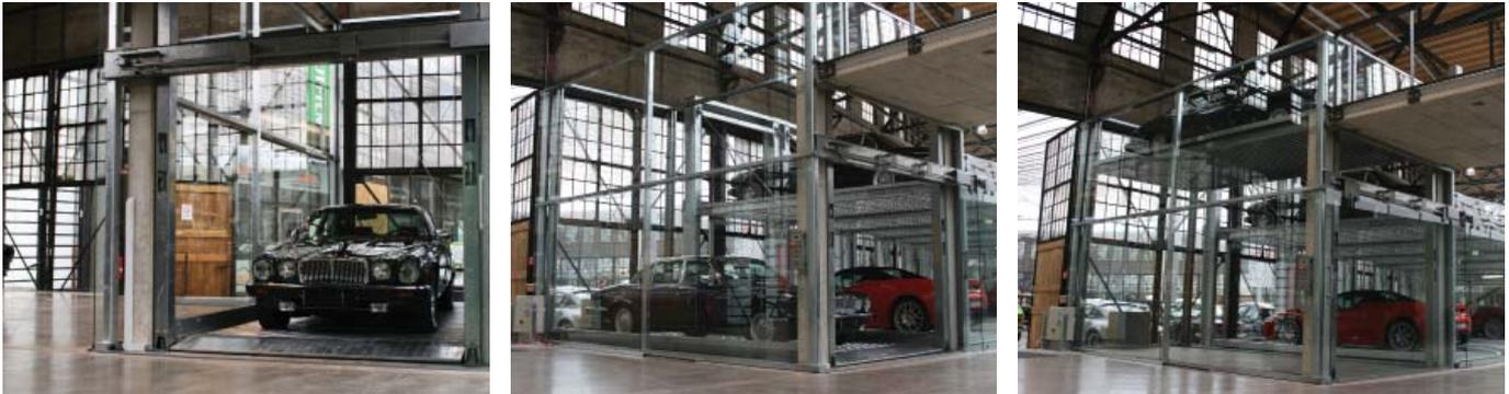
Hebeanlage angepasst auf das Design der *ClassicParker* – platziert in einem äußeren Ringbereich
